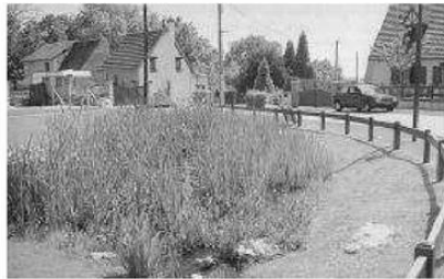
Noue engazonnée Opération Belbeuf – 76 Source Foncier Conseil
