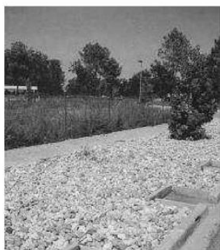
Tranchée sous-trottoir Av de la Grande Lande - GRADIGNAN - 33 Source CETE du Sud-Ouest.
