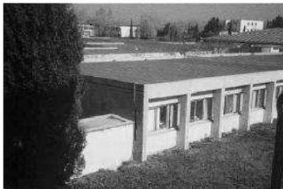
Toiture – terrasse Source CERTU
