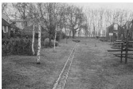
Noue et cunette en béton à Villabois Bruges (33) Source CETE du Sud-Ouest
