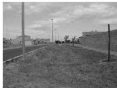
Noue en construction à Alénys Lotissement « les Vignes » Source DDE 66
