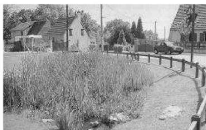
Noue engazonnée Opération Belbeuf – 76 Source Foncier Conseil
