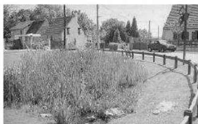
Noue engazonnée Opération Belbeuf – 76 Source Foncier Conseil
