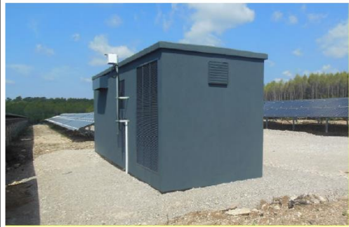
PHOTOGRAPHIE 20 : EXEMPLE D'HABILITAGE DE POSTE DE LIVRAISON (EN COURS DE REALISATION)
