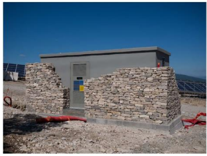
PHOTOGRAPHIE 20 : EXEMPLE D'HABILITAGE DE POSTE DE LIVRAISON (EN COURS DE REALISATION)
